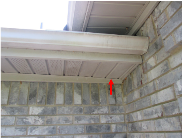
Loose soffit.
